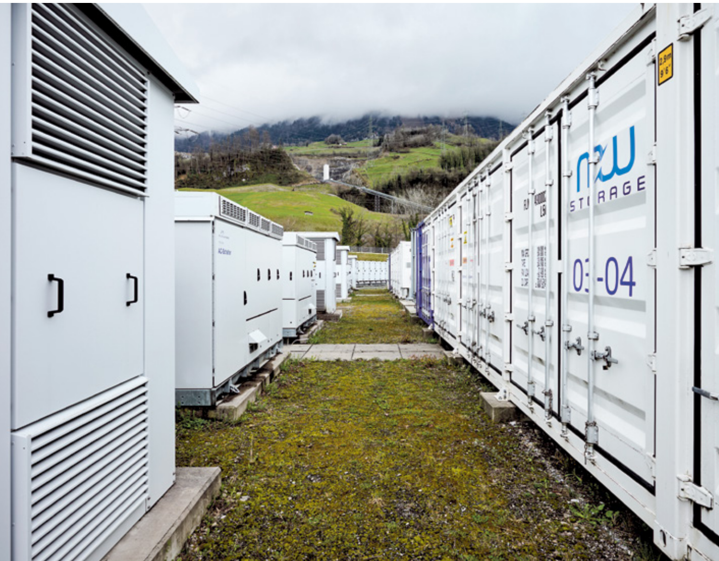
Die Anlage in Ingenbol umfasst 30 Container, in denen unzählige Batteriemodule untergebracht sind. Wachsendes Interesse stellen Experten auch bei Heimbatterien fest.
