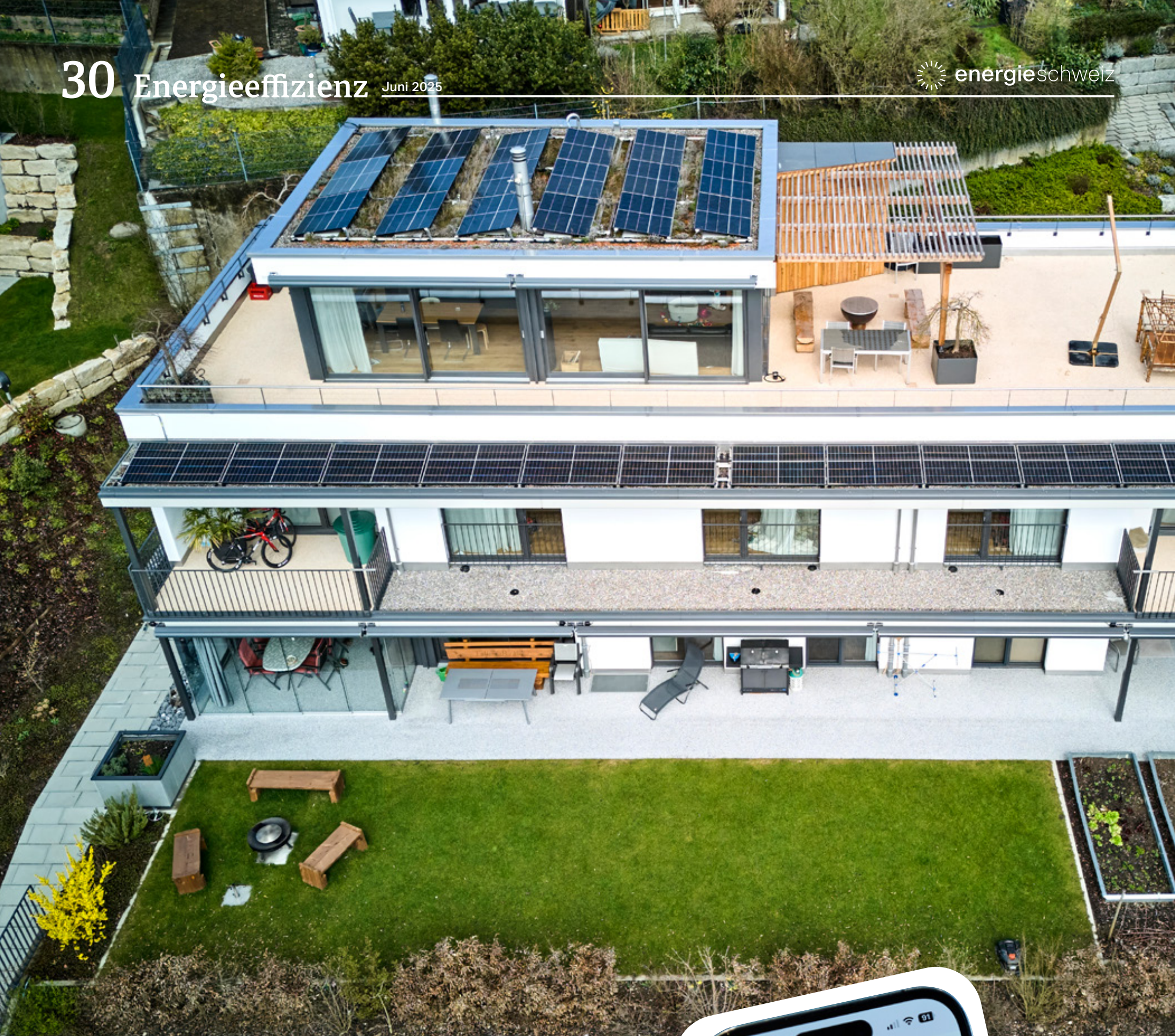
Das Wohnhaus in Schneisingen AG, ist Teil einer Neusiedlung – Silvan Diller teilt den Solarstrom mit den Nachbarn im Erdgeschoss.
