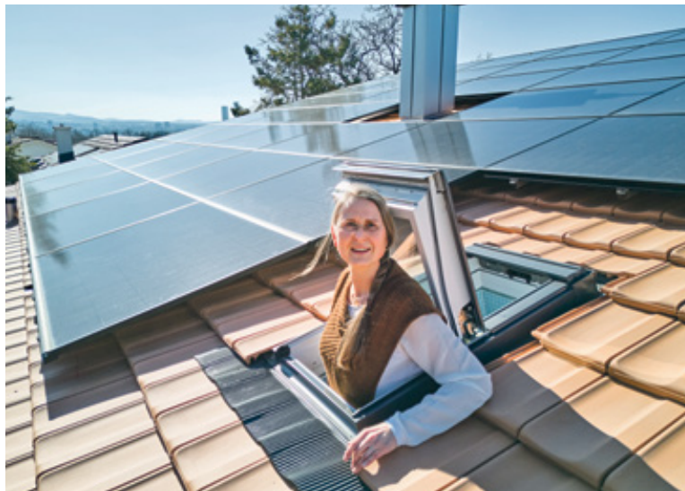
Die Hauseigentümerin hat für die PV-Anlage eine Aufdachlösung gewählt.
