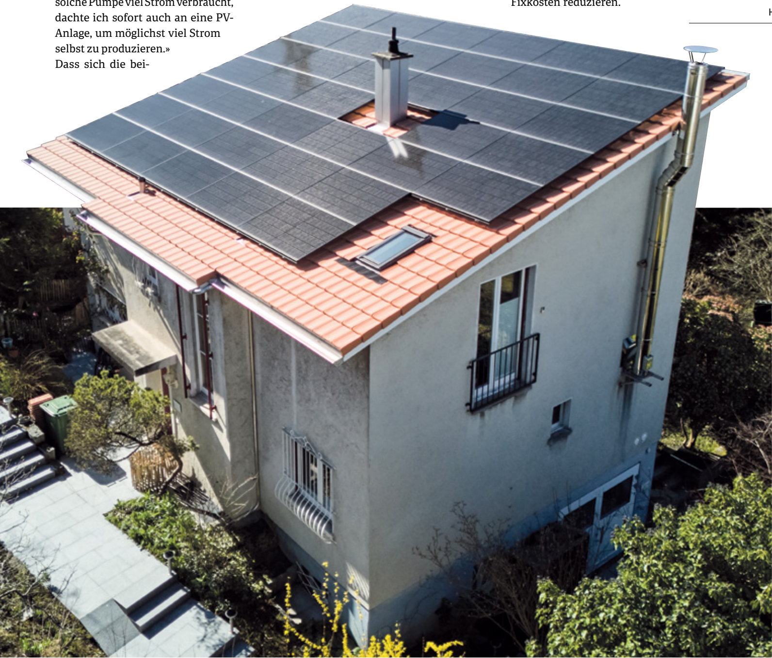
Beim Einfamilienhaus in Riehen wurden zeitgleich das Dach saniert und eine PV-Anlage installiert.
